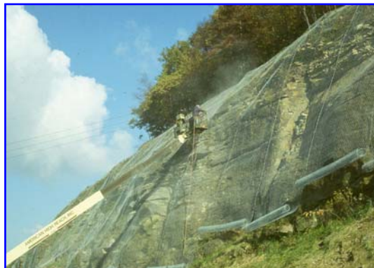
Foto 1 – Installazione di un intervento paramassi in parete, legatura dei teli di rete a doppia torsione
