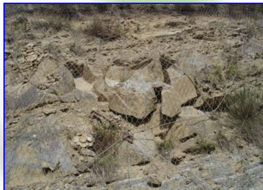
Foto 3 – La foto mostra l'effetto di ritenzione della rete e del reticolo di funi su blocchi distaccati
