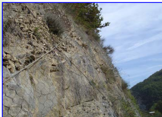
Foto 2 – Dettaglio di un intervento in parete realizzato con rete paramassi, chiodatura e tirantatura con funi in trefoli in acciaio
