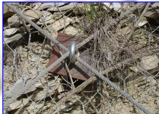
Foto 4 – Dettaglio della testa dell'ancoraggio, della piastra e del golfaro passacavo
