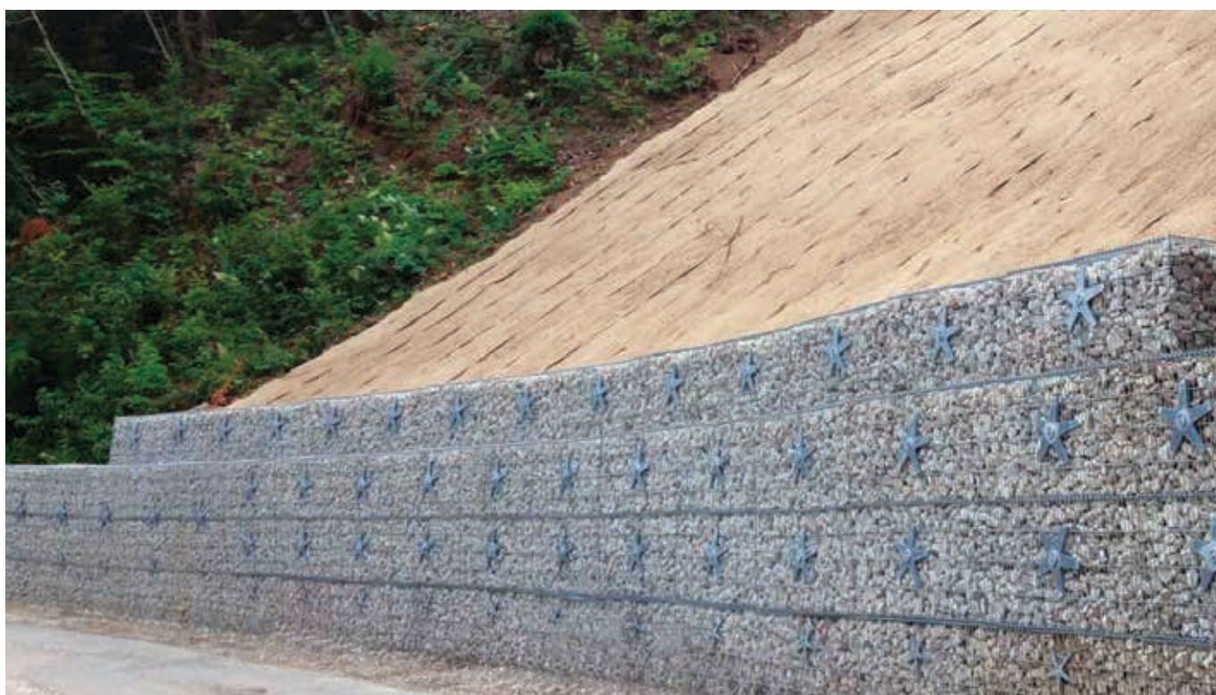
GABIONI UČVRŠĆENI ZA POKOS SISTEMOM SIDARA
